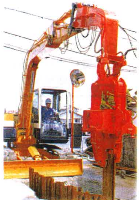
HP-2SX (下水道工事)
