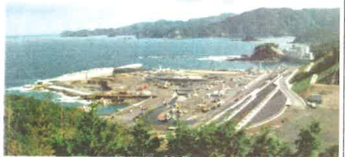
<敷地造成状況>
