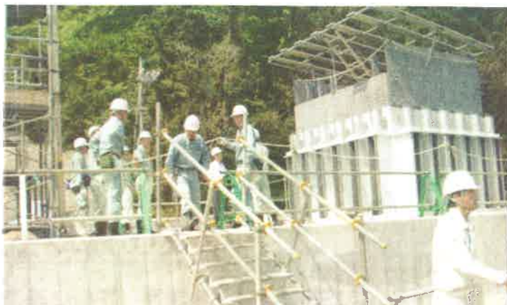
<研修会開催状況 豊島大橋 主塔基礎>
