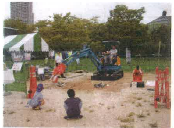
「解体現場で活躍する内装解体機」 協力会社 宝物産株式会社
