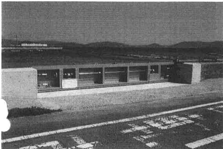
防潮ゲート (広島県廿日市市地御前地区)
