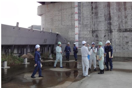
放水路分流堰
