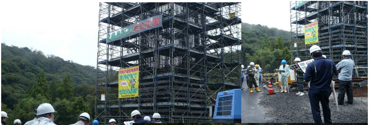
湖陵・多伎道路二部高架橋下部工事
