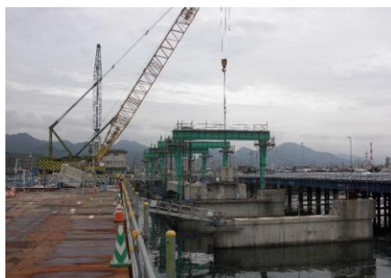
コンクリート桁の撤去
