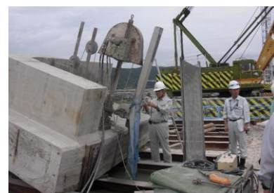
コンクリート桁の切断
