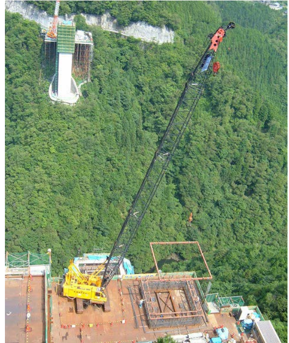
平成 15 年度 新丸山ダム国道 418 号新旅足橋下部工 (左岸) 工事
