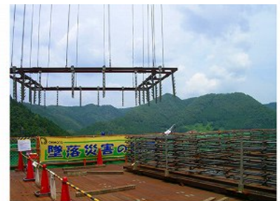
写真 2 組立鉄筋取り込み
