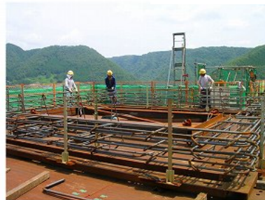
写真 1 鉄筋地組
