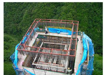
写真 4 鉄筋吊り入れ
