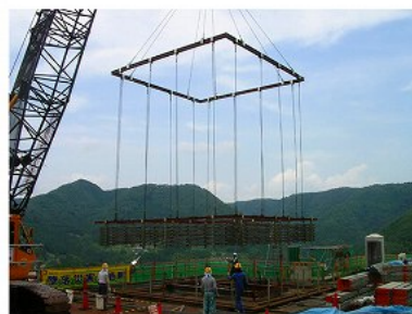
写真 3 鉄筋吊り上げ
