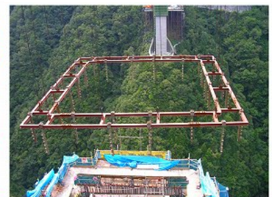
写真 6 吊り枠吊り上げ
