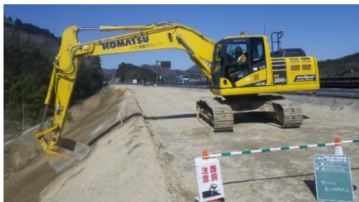
写真-1 MCバックホウによる盛土法面整形状況
