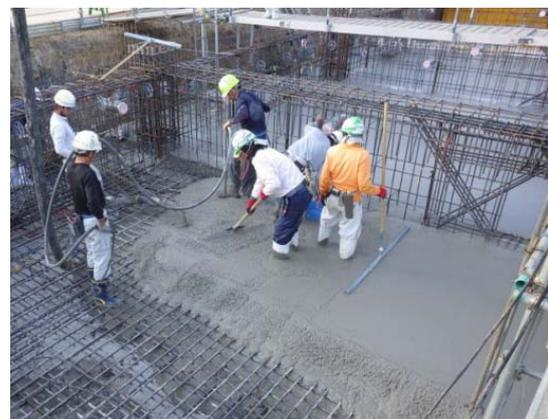
写真-1 LHCの打込み状況（耐圧版）
