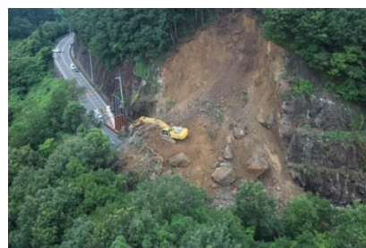
図-3 災害状況斜め写真（2015/7/23 撮影）
