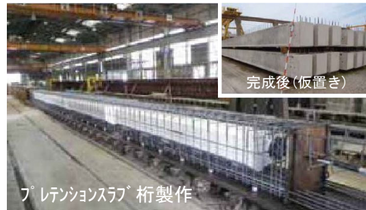
写真-1：PCaPC 桁 工場製作状況
