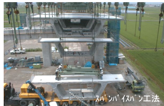
写真-2：セグメント桁部材 架設状況
