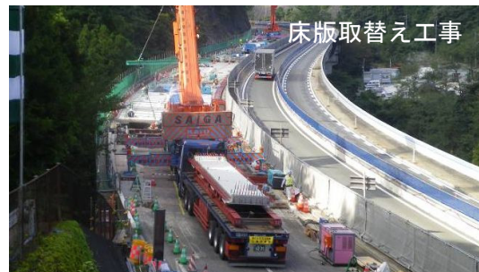
写真-3：PCaPC 床版取替え 架設状況
