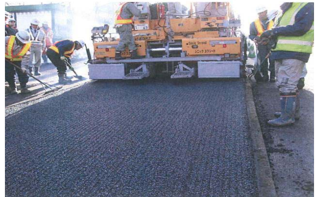
図-2 シニックスクリードによる縦溝粗面の形成
