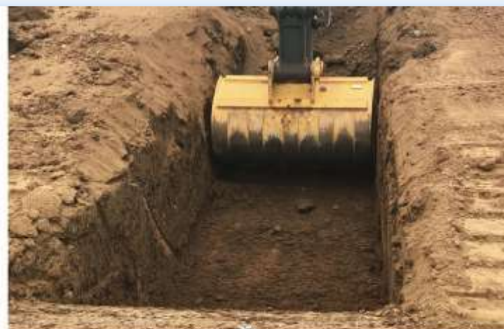
過掘りのない掘削が可能
