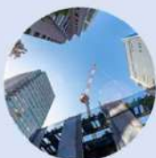
上空視界の狭い 都市部工事
