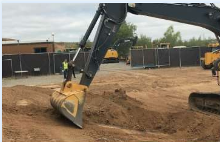
法面も設計データ通りに簡単に整形
