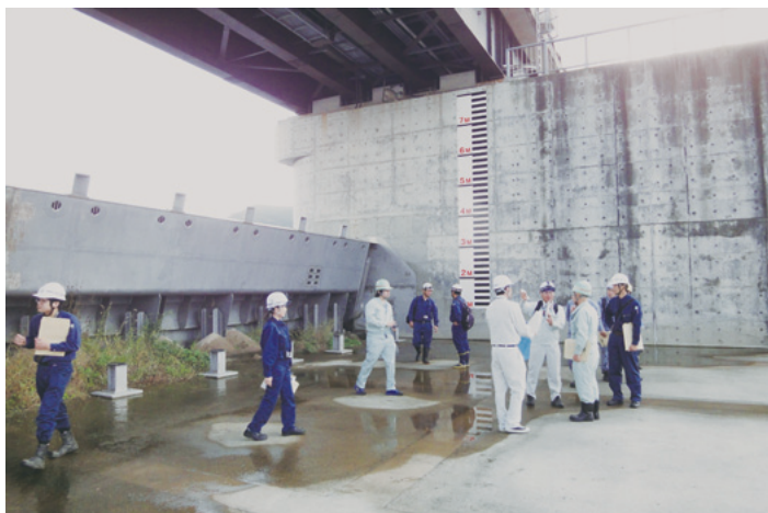
放水路分流堰
