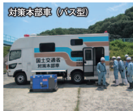
発電機設置作業
