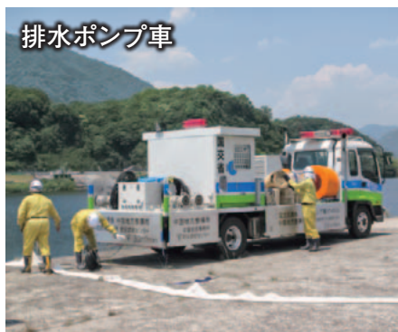
ホース設置作業
