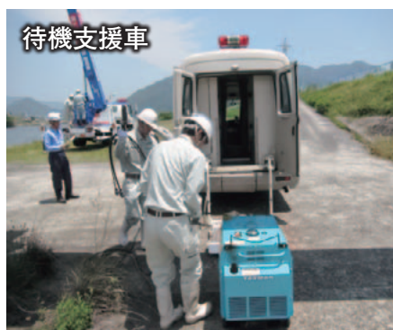
発電機設置作業
