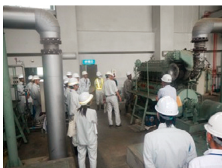
排水機場操作説明会 (岡山河川事務所)
