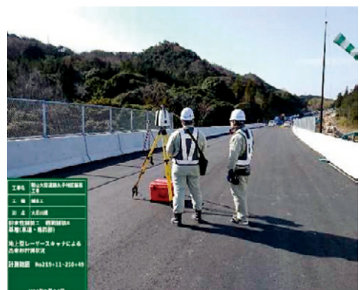
基層上面TLS測量「面計測」(計測間隔40m)
