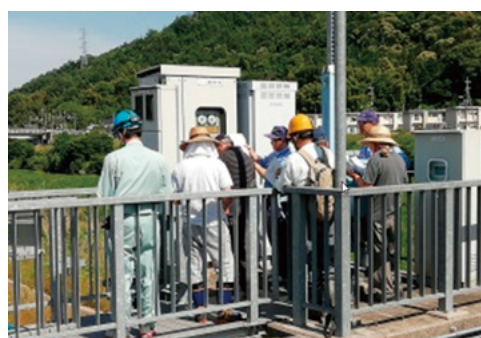
樋門操作説明会 (福山河川国道事務所)
