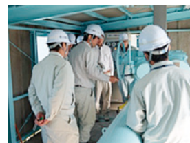
樋門設備の点検ポイント説明
