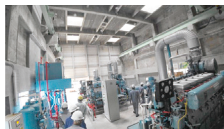
【十日市排水機場】
