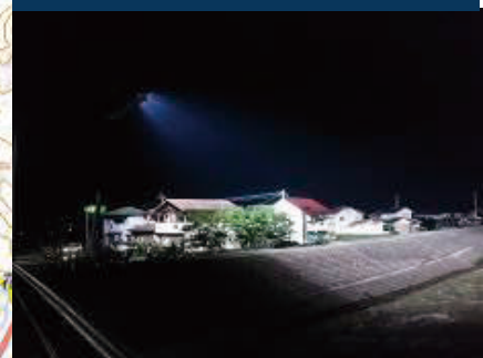
【筑後川水系 花月川】 護岸の緊急復旧工事 ・照明車 2台
