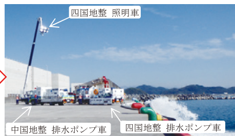
排水ポンプ車による排水活動訓練
