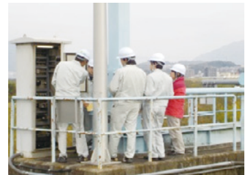
樋門設備の操作、故障対応説明
