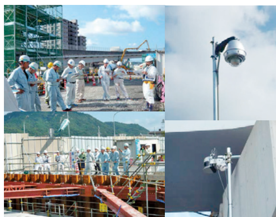
《東広島B P 海田高架橋下部工事》
