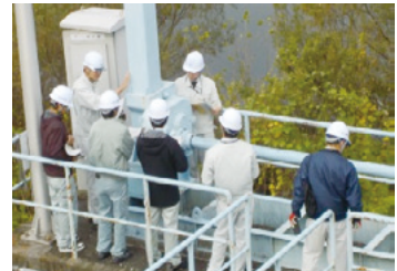
樋門設備の点検ポイント説明
