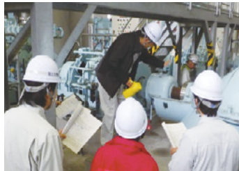
ポンプ設備の点検ポイント説明
