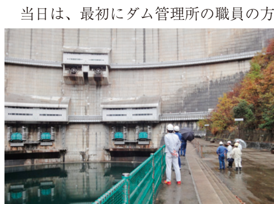
下流より（主放流設備・中位標高放流設備）
