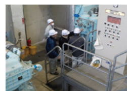
ポンプ設備の操作体験
