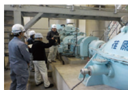
ポンプ設備の点検ポイント説明
