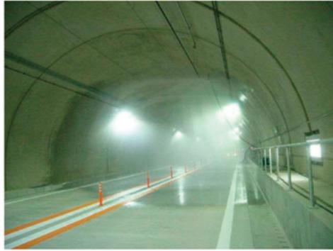
尾道・松江自動車道 大万木トンネル非常用設備工事（水噴霧試験中）
