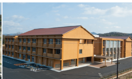
校舎建築工事
