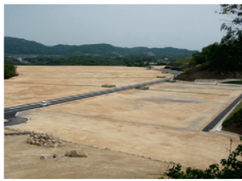
工事名: 三次地区土地造成事業(Ⅲ期)土地造成工事 発注者: 広島県
