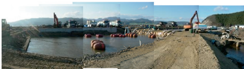
追波川排水機場(石巻市)における排水作業
