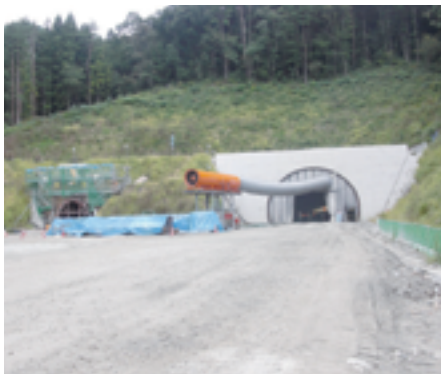
トンネル坑口
