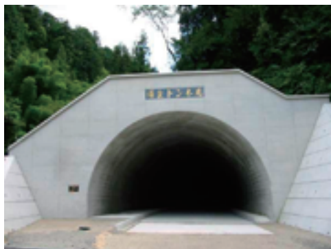
須金トンネル (山口県)
