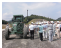
情報化施工施工状況
