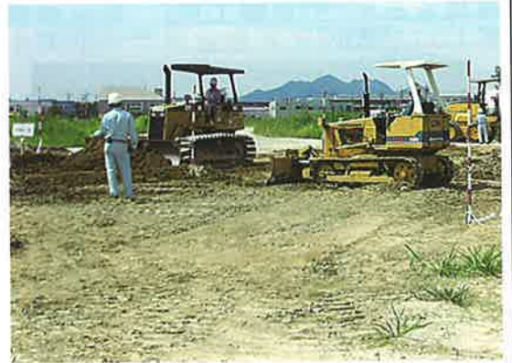
実地試験 (建設機械操作施工法試験)
