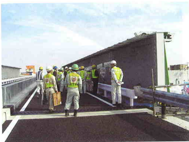
<すいすいMOP工法>
