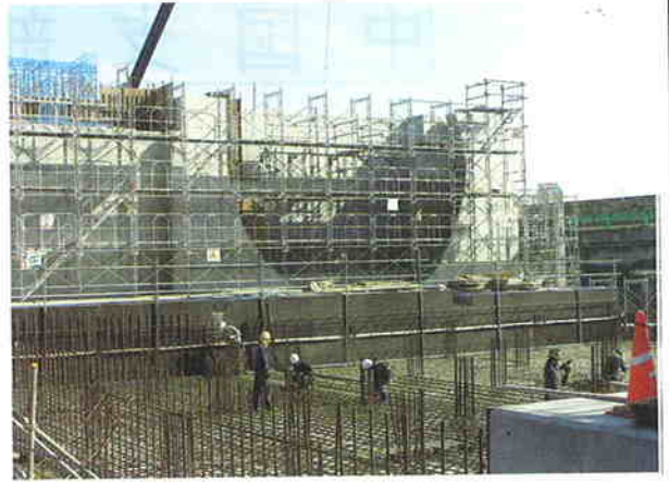
<水門の本体工事>
