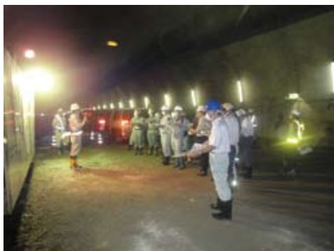
尾道松江自動車道現場見学会（H22）
