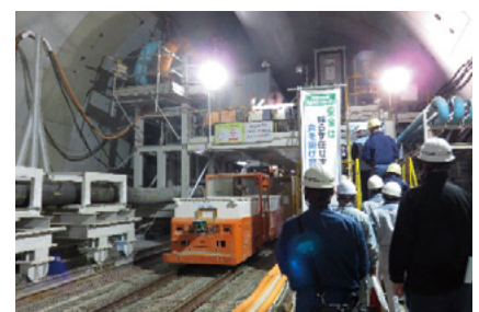
【第二部(現地)：シールドトンネル内】
