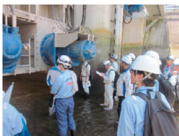
ポンプゲート2門（1.625m 3 /s×4台）
