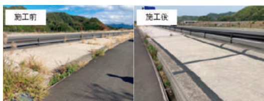
改質アスファルト系シートによる目地防草対策 〔谷口産業株式会社〕
