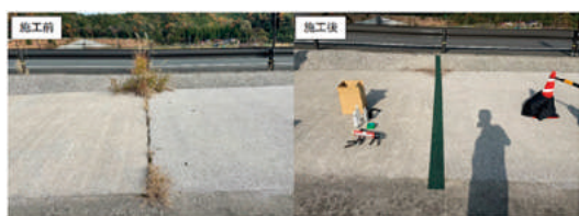
目地ガードシートを使用した目地防草対策 〔谷口産業株式会社〕
