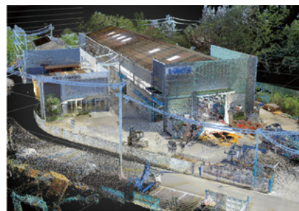
点群取得例：日本マーツ株式会社 整備工場
