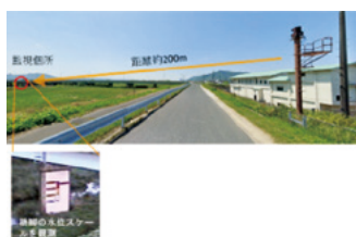
IOTカメラによる河川水位監視システム〔(株)イクシス〕
