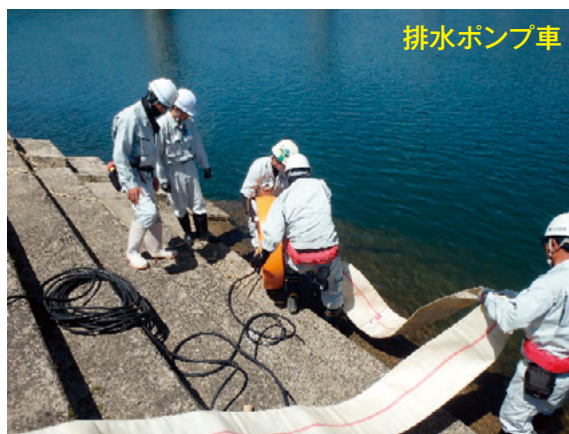
写真-2 水中ポンプ投入状況
