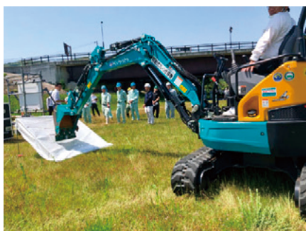
ICT小型建機による模擬掘削実演
