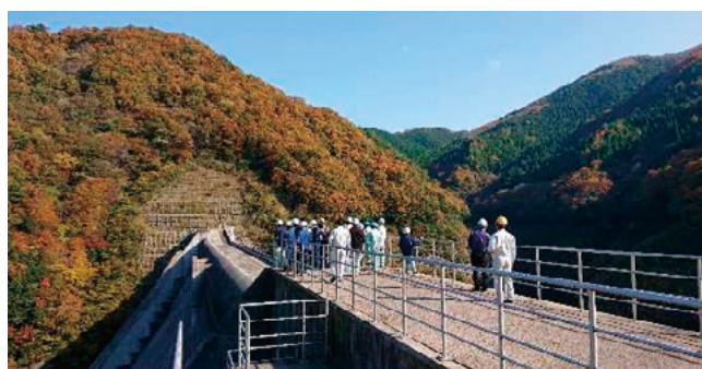
堤体の視察状況
