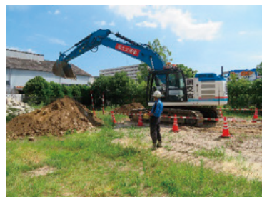
写真-3 遠隔操縦訓練状況
