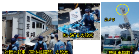
災害対策用機械と通信機器を組み合わせた設備設営
