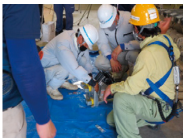
写真-2 遠隔操縦装置アーム組立
