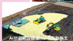
AI搭載建設機械による自動施工
