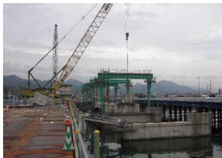
コンクリート桁の撤去
