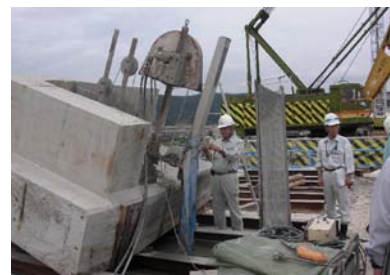
コンクリート桁の切断
